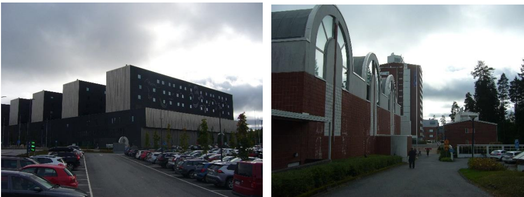
Kuva 6. Alueen rakennettua ympäristöä hallitsevat suuret sairaala- ja oppilaitosrakennukset.
